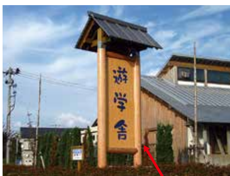
遊学舎（秋田市）の看板の円筒形柱材は単板 積層材で成型したものです。
