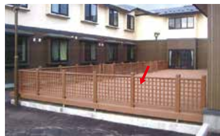
ケアハウス樹海の里 (大館市)
