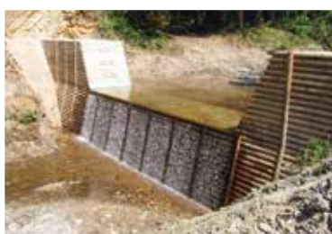
災害関連緊急治山 (男鹿市)
