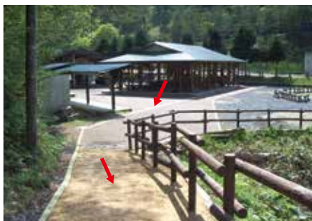
大館少年自然の家（大館市）の野外研修広場。 2種類の木質系舗装材を使用しています。
