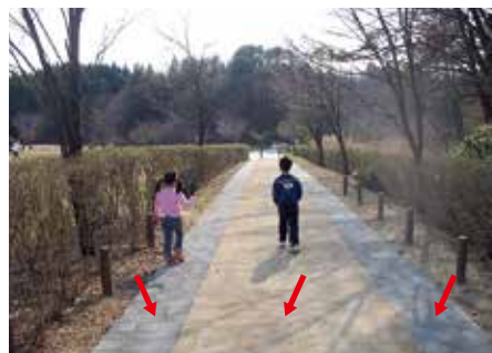
県立小泉湧公園（秋田市）の園内歩道。 中央部分には木質系舗装材、路肩部分には 溶融スラグ入りコンクリート板を使用し、 管理用の軽車両が通行できる構造です。
