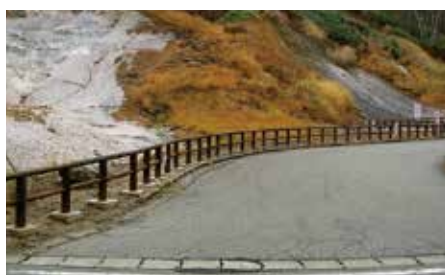
泥湯温泉駐車場 (湯沢市)
