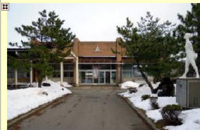
中央調査班の正面玄関
