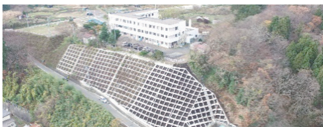
急傾斜地崩壊対策工事（男鹿市船川港女川）
