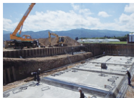
地域の環境を良くする仕事 (工場排水処理施設の工事風景)
