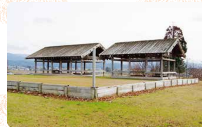
板塀に区画された掘立柱建物（E期復元、北西から）
