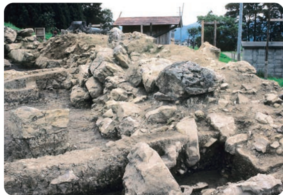
地震で瞬間的に地面が動いたことにより、「だるま落とし」のように階段状に横ずれした石塁のようす
