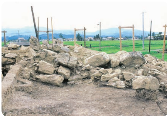
地震で瞬間的に地面が動いたことにより、「だるま落とし」のように階段状に横ずれした石塁のようす
