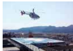
屋上ヘリポート
